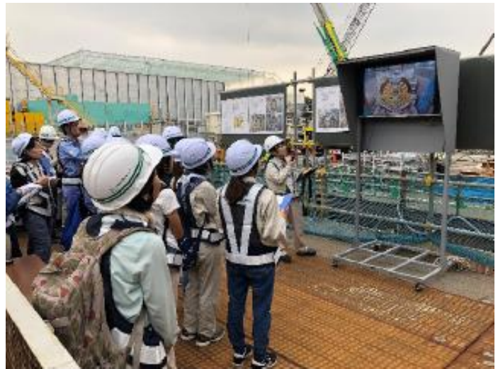
シールドマシンの組み立て動画確認
