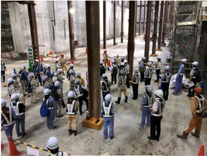
開削工事現場の様子
